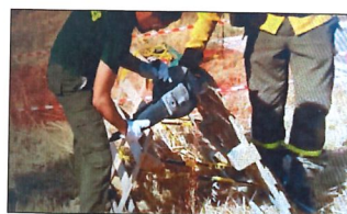
Foto de trabajos con radial.
